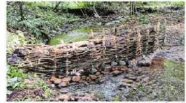
പാറമീശ്ശേരിയിൽ നിർമ്മിക്കുന്ന 36 ചെക്ക്ഡാമുകളുടെ ഭാഗമായി പാറമീശ്ശേരിയിൽ 36 ചെക്ക്ഡാമുകളുടെ നിർമ്മാണം നടക്കുന്നുണ്ട്. ഇതിൽ 15 വീടുകളിൽ സഹായകരമായ വടക്കൻ മേഖലയിൽ 100 ബ്രഷ് വുഡ് ചെക്ക്ഡാമുകൾ നിർമ്മിക്കുക എന്ന ഉദ്ദേശ്യമുണ്ട്. ഇതിൽ 36 ചെക്ക്ഡാമുകൾ മാത്രം പൂർത്തിയാക്കിയിട്ടുണ്ട്.
